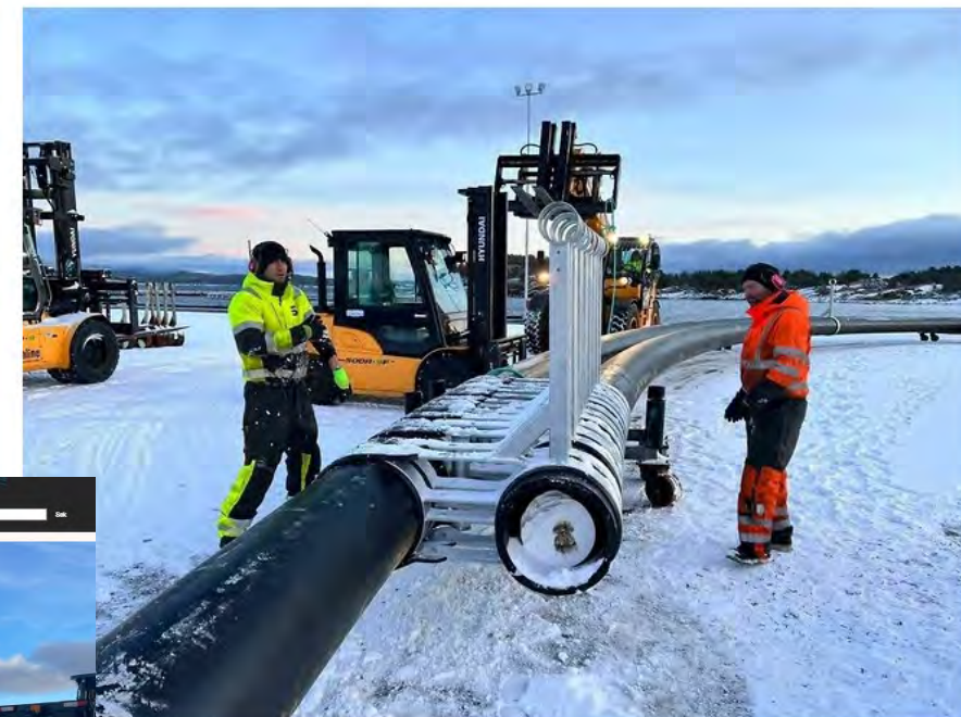
Grønn plattform: Nye klammere blir tredd innpå de resirkulerte flytekragene. Foto: ScaleAQ
